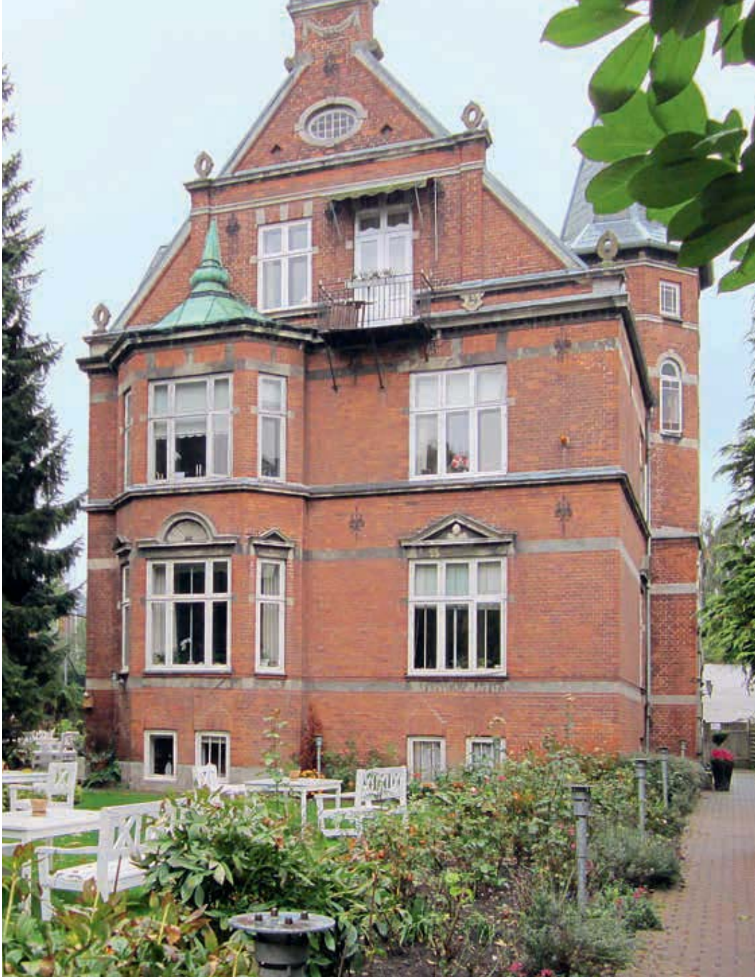
Diese alte Villa liegt in einem zentralen Stadtteil von Kopenhagen. Sie beherbergt 23 pflegebedürftige Menschen. Das Leben in diesem Haus ist außergewöhnlich.
